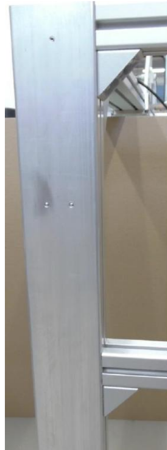
Abbildung 11: SMS-I-40x80: Beispiele zur Verbindung Hubelement mit Grundrahmen mittels handelsüblicher Anbindungswinkel (klein/groß)
