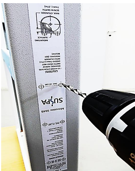
Abbildung 8: Bohren der Löcher
