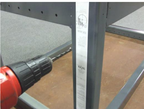
Abbildung 7: Bohren der Löcher
